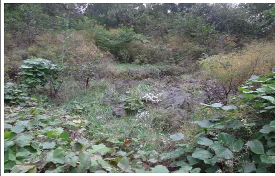
사면(종점부) STA.0+25m 자연사면 암노출
