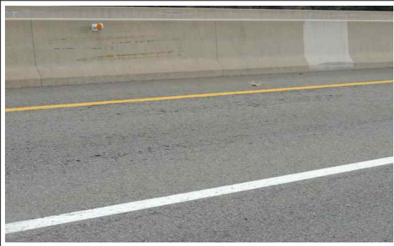
교면포장 상행선 S11 라벨링
